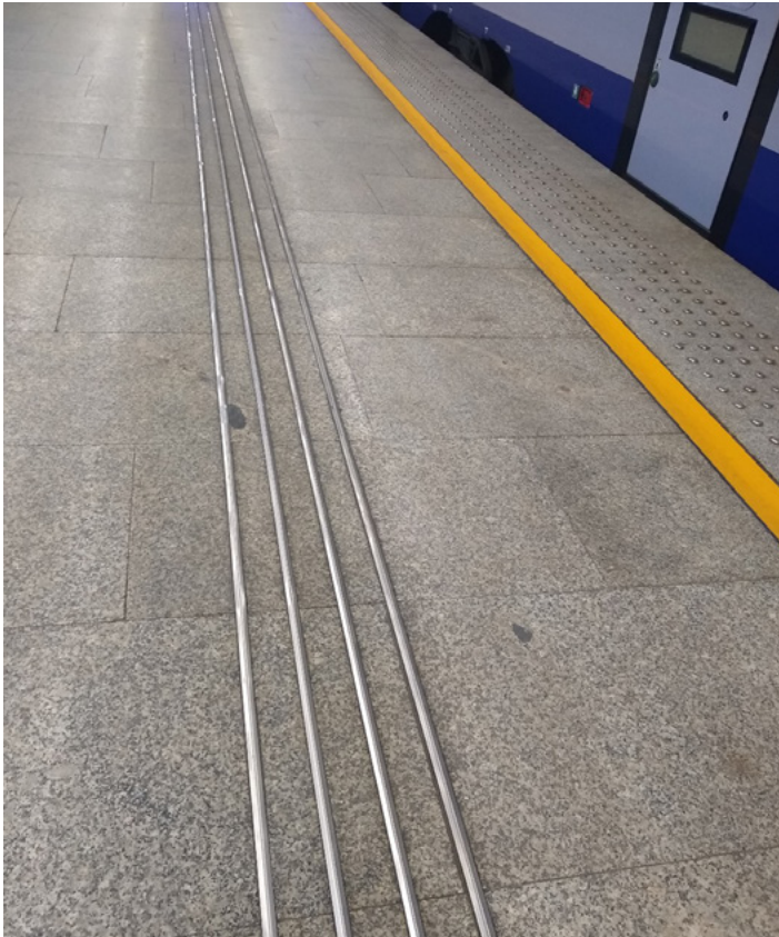
Rysunek 47. Przykład wyczuwalnych dotykiem powierzchni ze wzorem ostrzegawczym od strony krawędzi peronu i ścieżką naprowadzającą po bezpiecznej stronie peronu Fot. materiały własne.
