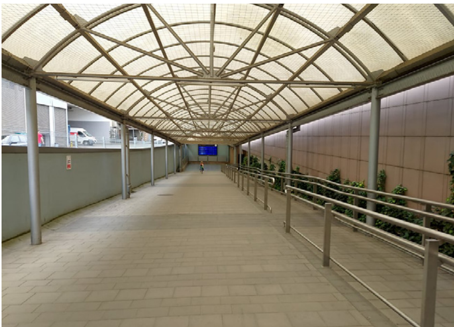
Rysunek 23. Wejście w podziemia na dworcu Kraków GłównyFot. materiały własne.
