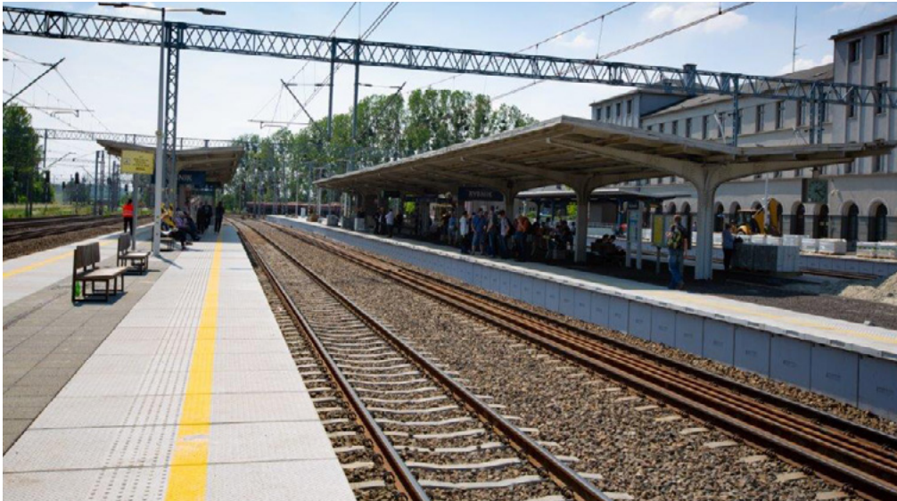
Rysunek 48. Peron na dworcu kolejowym w Rybniku, modernizacja w ramach POIiŚ Fot. PKP PLK ( https://www.plk-sa.pl/biuro-prasowe/informacje-prasowe/inwestycja-plk-zwieksza-mozliwosci-kolei-w-rybniku-3780/ )
