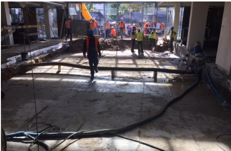
Akcja usuwania posadzki wraz z elementami ogrzewania oraz płyt ceramicznych
