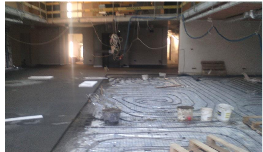
Ponowne układanie instalacji ogrzewania oraz wykończenie podłogi po osuszeniu podłoża
