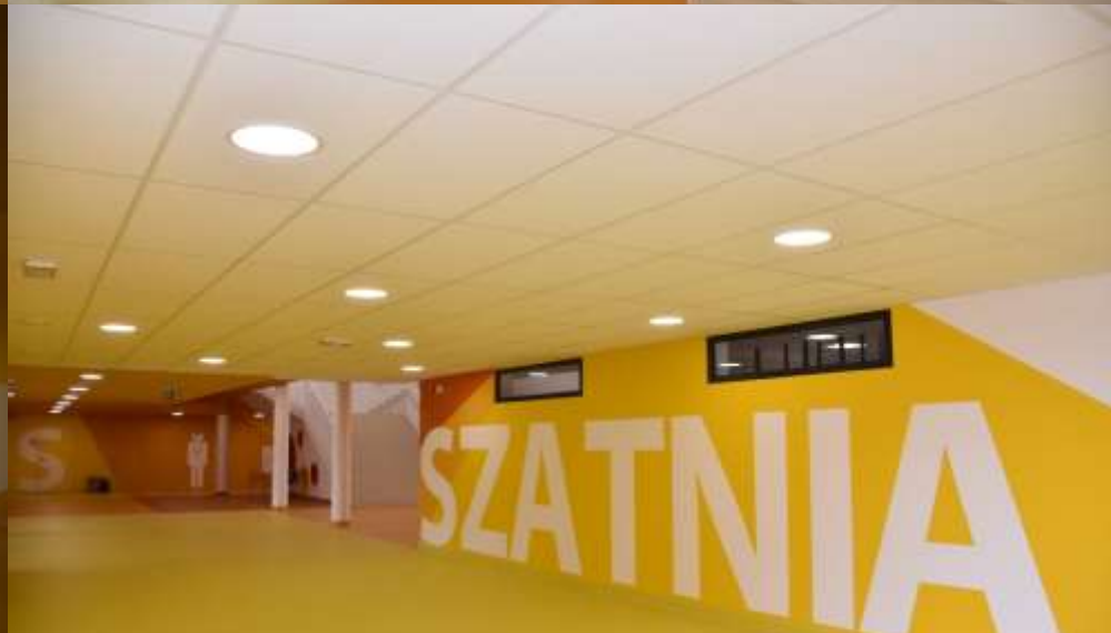
Hall główny z sufitem akustycznym ograniczającym odczuwalny poziom hałasu
