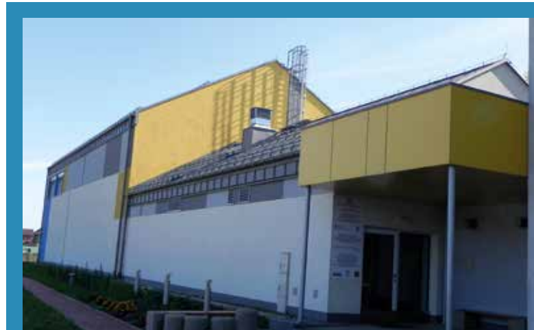
Waganowice, sala gimnastyczna
