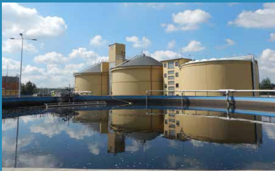
RCGW S.A. Tychy, komory do hybrydowej produkcji biogazu
